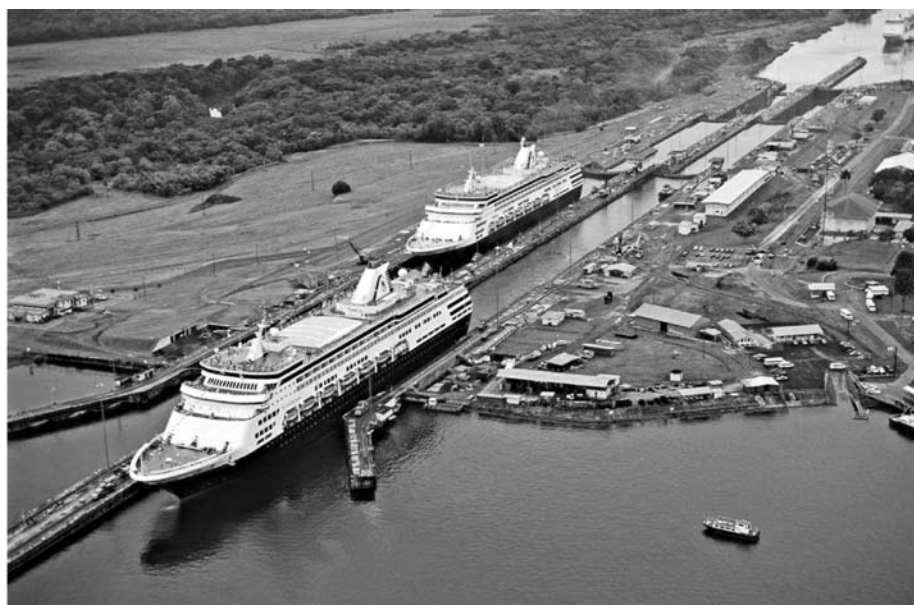
Rys. 8. Śluzy Kanału Panamskiego wyznaczają parametry „panamaksu”, tj. maksymalne wymiary statku, który może przejść przez Kanał – szerokość 32 m, długość 305 m
