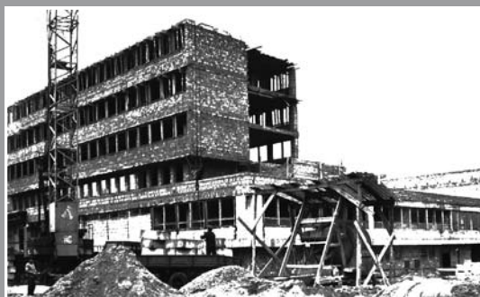
Budowa siedziby KW PZPR w Białej Podlaskiej - 1989 r.
